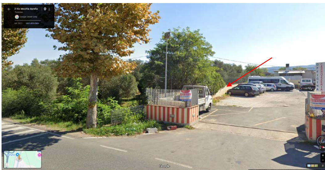
Figura 4-2: Immagine del muro in cls collocato al confine tra la proprietà della carrozzeria e l'area a verde. Google Maps, Street View
