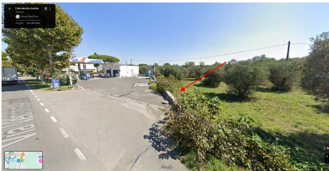
Figura 4-1: Immagine del muro in pietra collocato al confine tra la proprietà del distributore Q8 e l'area verde (uliveto). Google Maps, Street View
